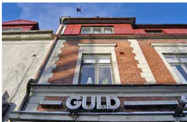
Exteriör mot Storgatan med spiktegelfasad, vitputsade hörnkedjor, gördelgesims och korspostfönster med vitputsade omfattningar och profilerade överstycken.
