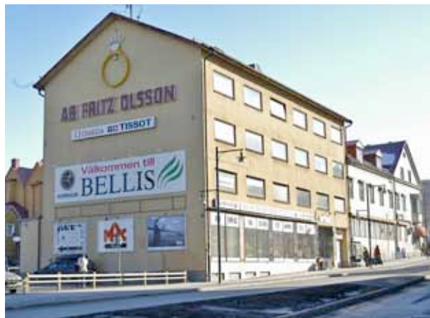
Funkishuset och hörnhuset är nära sammanbyggda utvändigt och invändigt. Här byggnadernas fasader mot Smedjegatan samt funkishusets nordvästfasad som sedan 1966 pryts av Fritz Olssons karaktäristiska "dianantring". Foto från nordväst. Foto 2007-03-27
