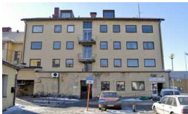
Funkishusets gårdsfasad. Foto från nordost. Foto 2007-03-27
