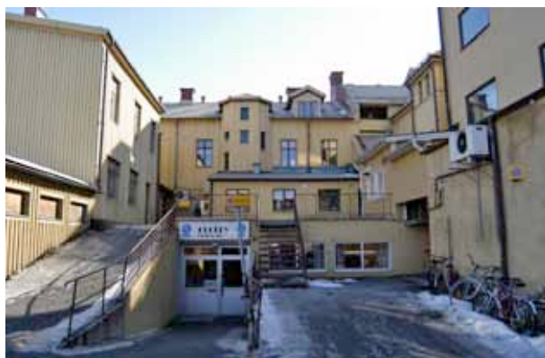
Gårdsmiljön från nordväst. Till vänster den tidigt tillbyggda flygeln, i förgrunden Elcitys entré i den överbyggda lokalen. I bildens mitt spiktegellhusets gårdsfasad. Foto 2007-03-27
