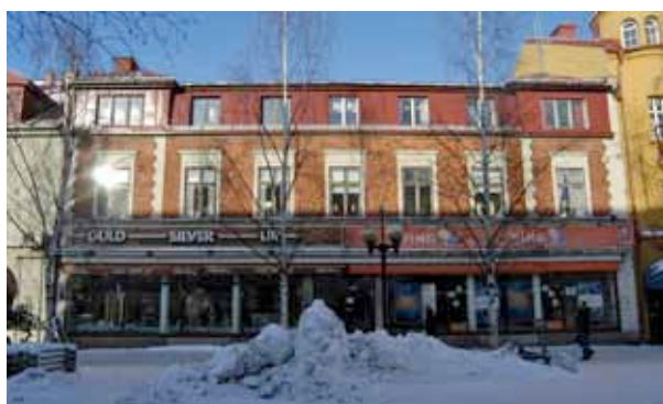
Byggnadens sydostfasad mot Storgatan. Foto 2007-02-22
