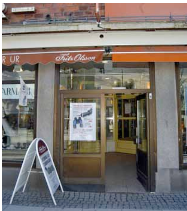
Nuvarande centrerad entré mot Storgatan.
