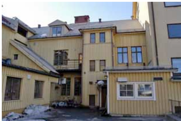
Gårdsfasaden från nordost med tillbyggnader från olika år. Foto 2007-03-27
