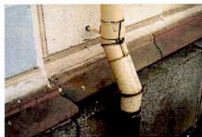
Detalj av sockel och puts. Under plastfärgen finns ursprunglig kalkfärg.
